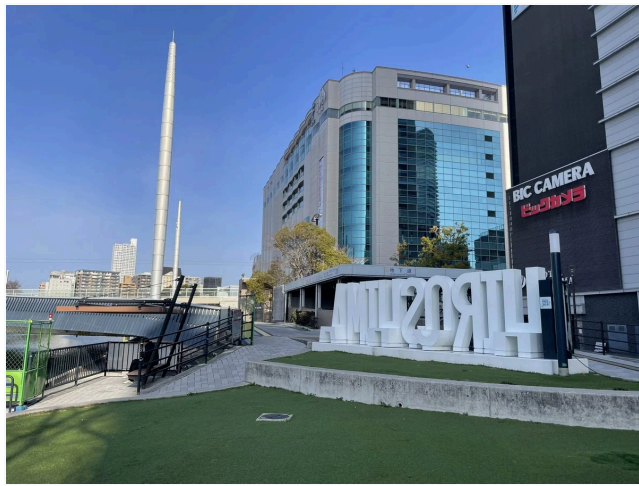
地下へのエスカレーターとエレベーター
